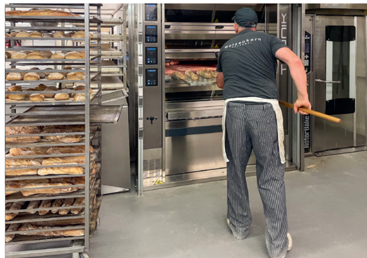
Einbau und Inbetriebnahme des neuen Ofens
