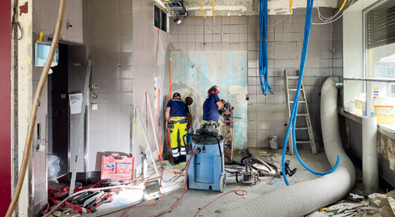
Einbau der neuen Hotelküche
